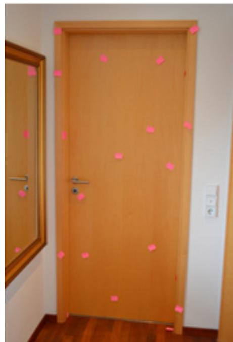
*Eine solche Abnahmesituation ist nach den Regelwerken nicht zulässig. Die Markierungen sind vor der Prüfung zu entfernen.*
